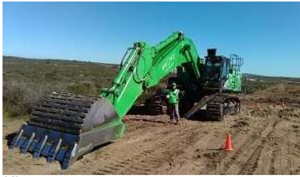
A Kropz excavator.
